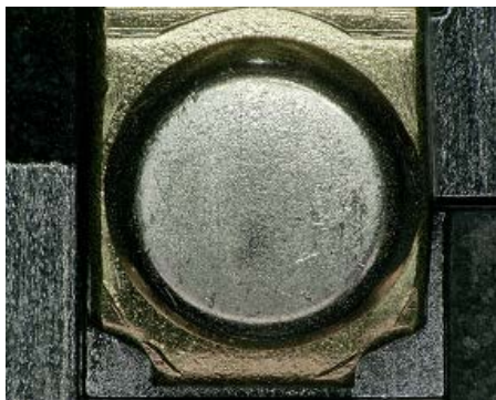
遮断器等の接点
