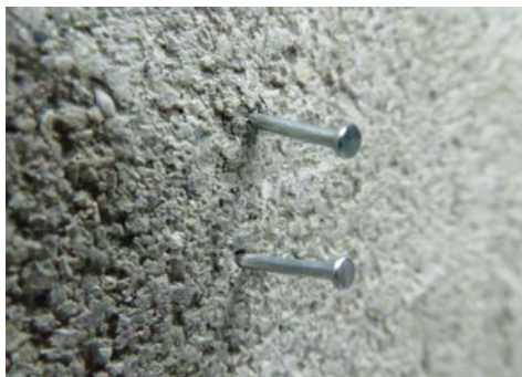
壁に打ち付けた製品のコンクリートピン
